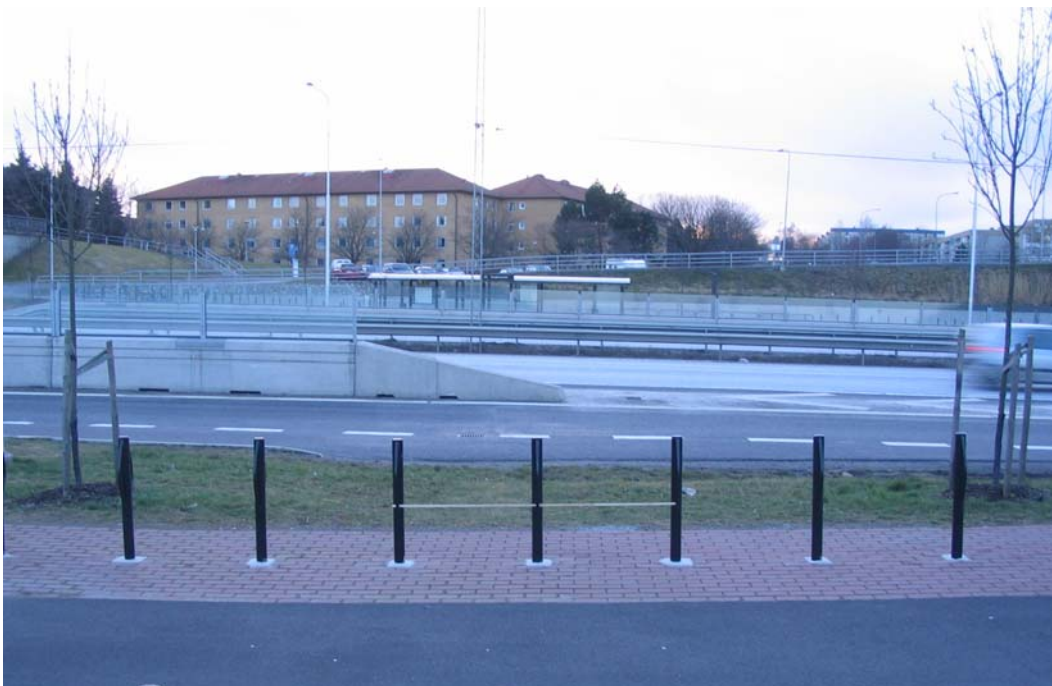
Figur 13 Bullerskärmarna ger både ett visuellt och ett fysiskt hinder mot spontana passager över motorvägen.
