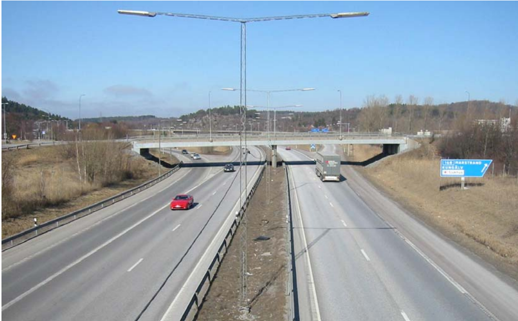
Figur 2 Foto taget norrut där motorvägshållplatsen senare anlades.
